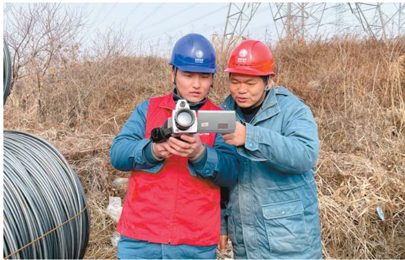
许廷宾(右)正和同事用测温仪测量线路温度是否正常。
