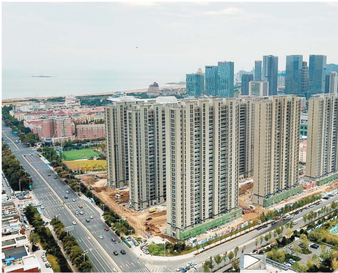
2020年10月10日,朱家洼佳源建筑外立面已经完工。
