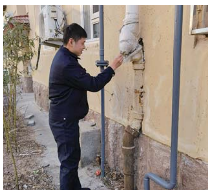
仔细检查每一栋楼院的管道。
