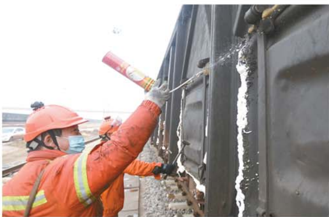
师傅们正在对车厢的缝隙处打泡沫填缝剂。
