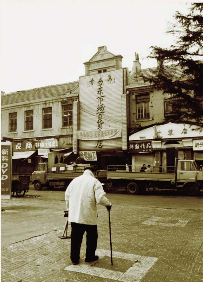
台东商场拆除前曾是光陆戏院(于向阳 供图)
