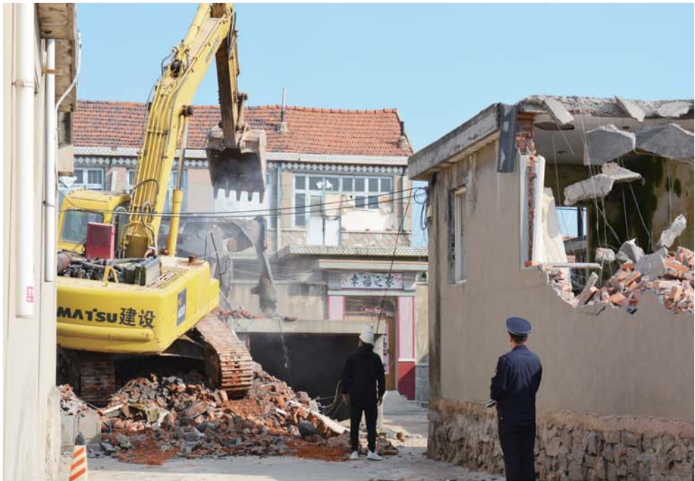
拆除旧村现场。
