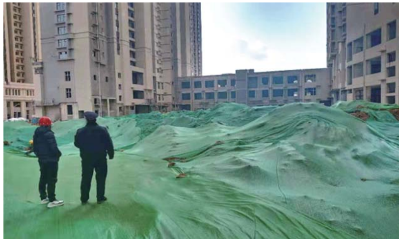
八大湖中队执法人员整治辖区工地,避免扬尘污染。
