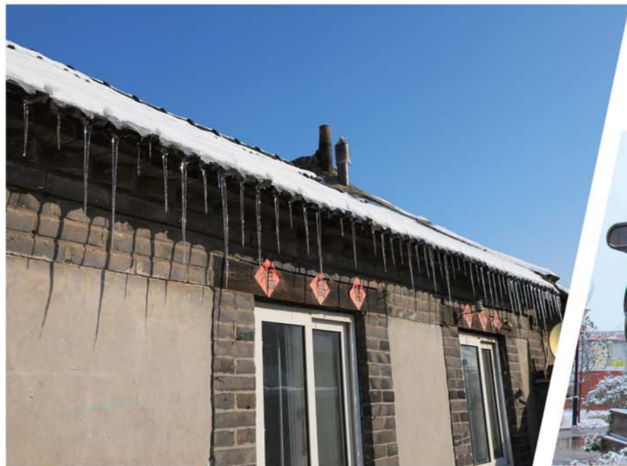
老屋的凌柱柱。
