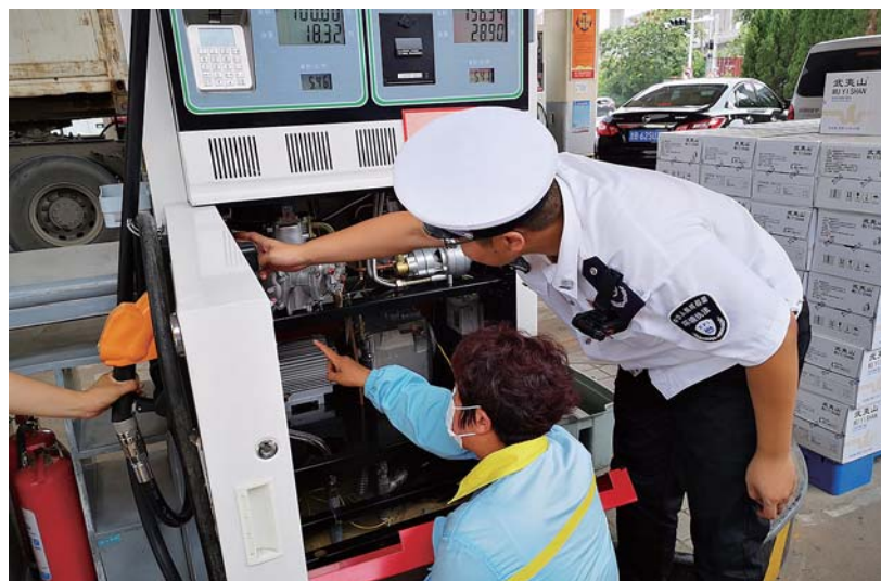
检查加油站油气回收在线监控系统安装情况。
