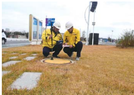
管网巡视人员检测阀门有无漏气
