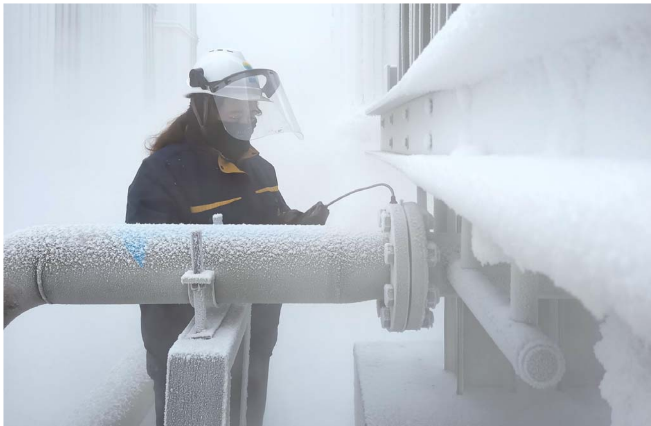
场站运行人员设备除霜及巡视
