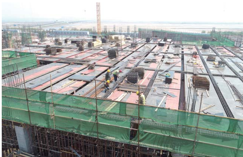
里物流山东区域运营中心项目。
