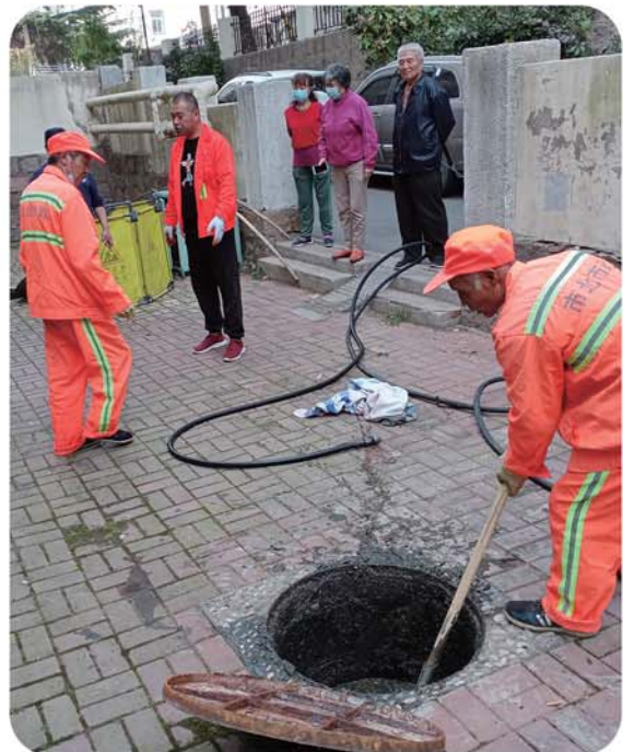
工人在污水管道清理现场进行施工。
