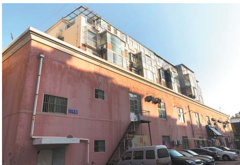
43号楼1~2层是商业网点,3~5层是住宅楼。
