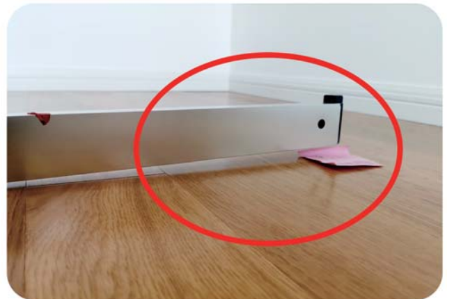
木地板表面平整度相差15毫米。
