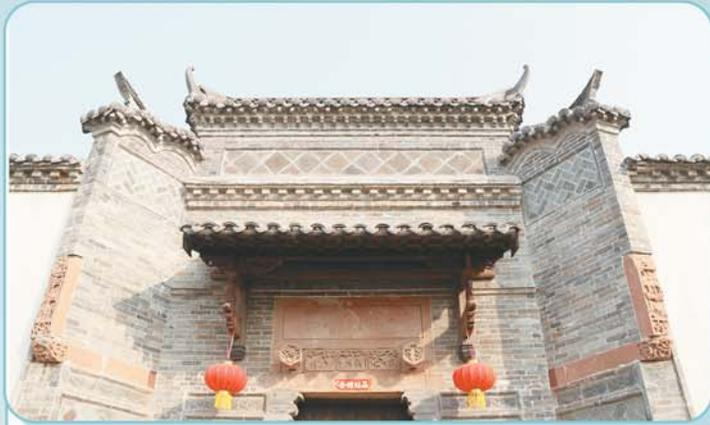
门罩指较为简单的门楼样式,通常是在门头墙上用青砖全砌出不同的形状,在顶部砌出仿木结构的屋檐,并镶嵌砖雕作为装饰。门罩上常置屋檐,檐下有瓦,可以遮挡风雨,保护檐下构件和门头上方的墙面。传说当年朱元璋攻占徽州后,一次出门拜访贤士时,半路遭遇大雨,便在路边一户人家门框下避雨,但是风雨太大,门框无法遮拦,最终被雨淋得浑身湿透。后来,朱元璋做了皇帝,在一次批阅徽州人奏折时,想
