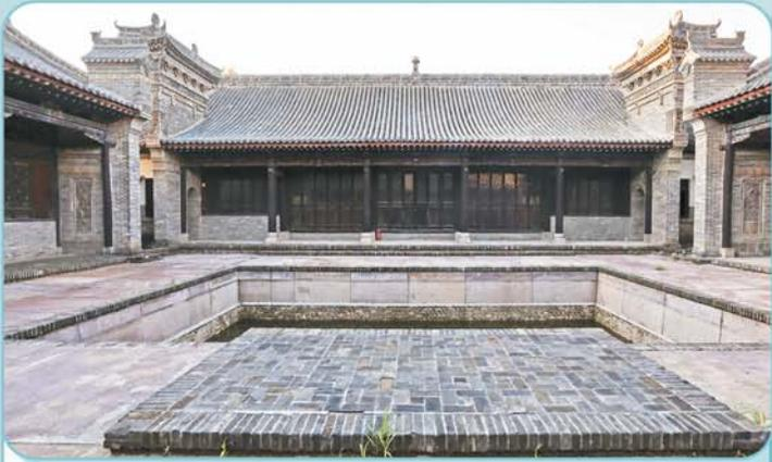
中国院子北方22号院又名梦墨堂,原址位于陕西西安近郊。房屋为北方典型四合院形式,以北为正,正房面阔五间,两侧设耳房,南面倒座房三间,东西厢房为三间,各房皆设外檐廊。一层砖木结构,总建筑面积为765.72平方米,内院中间设有水池,东西房山墙和南北房前墙间各留一间隙,为风道。院内部砖雕、彩绘琳琅满目,砖雕题材以植物结合祥鸟为主,寓意美好吉祥;檐廊木挂落及屋内房顶彩
