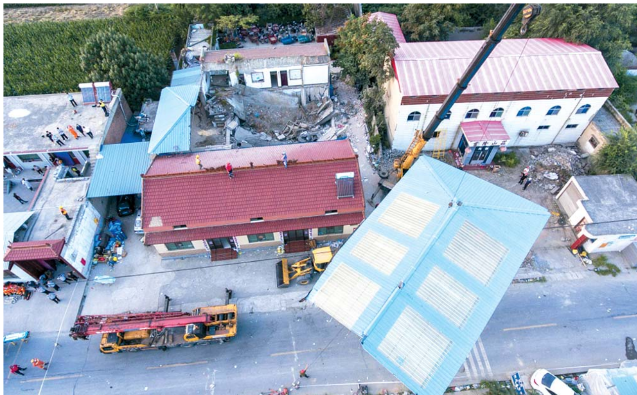
这是8月29日拍摄的事故救援现场(无人机照片)。新华社发
