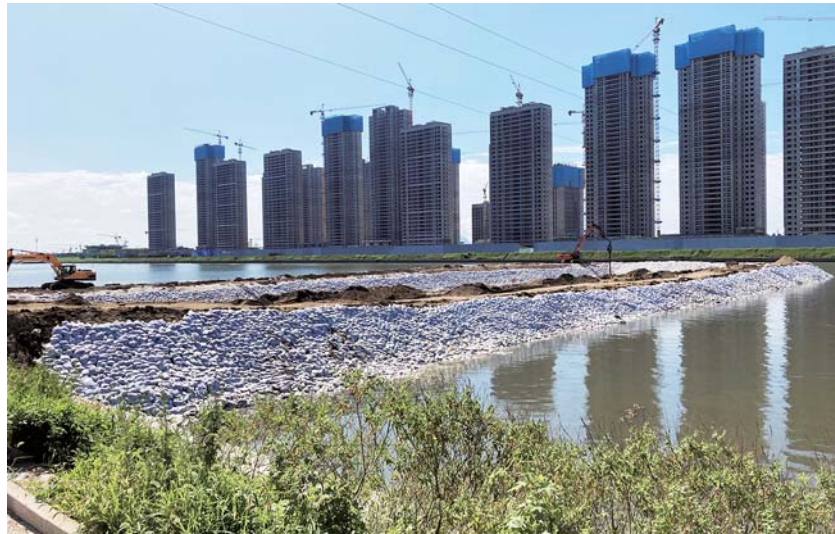
管线改迁工程施工现场。
