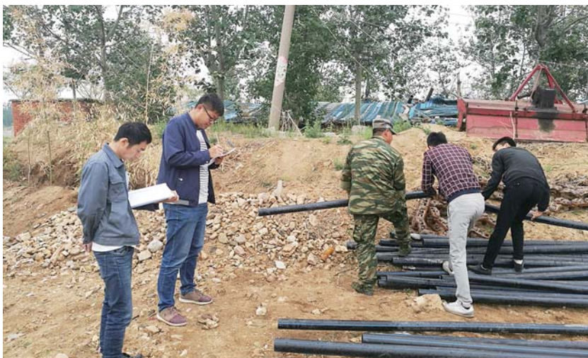
安装管网提高供水保障能力及规模化供水覆盖率。
