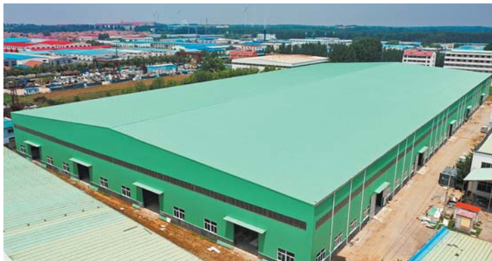
即将竣工的青岛晟嘉琪项目。
