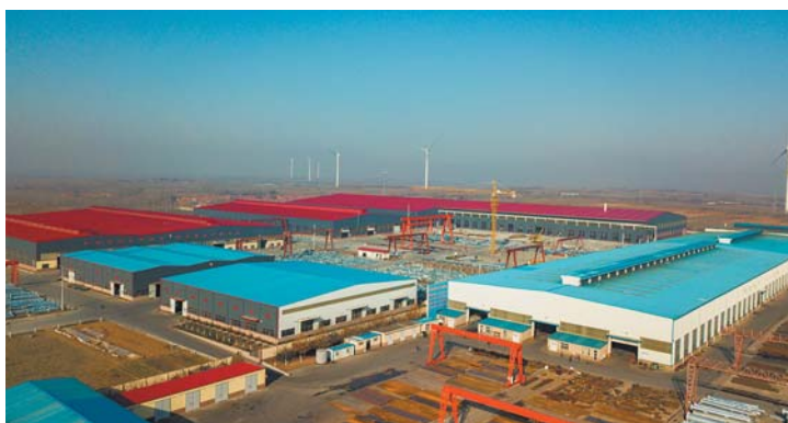
华电海洋装备产业园项目。
