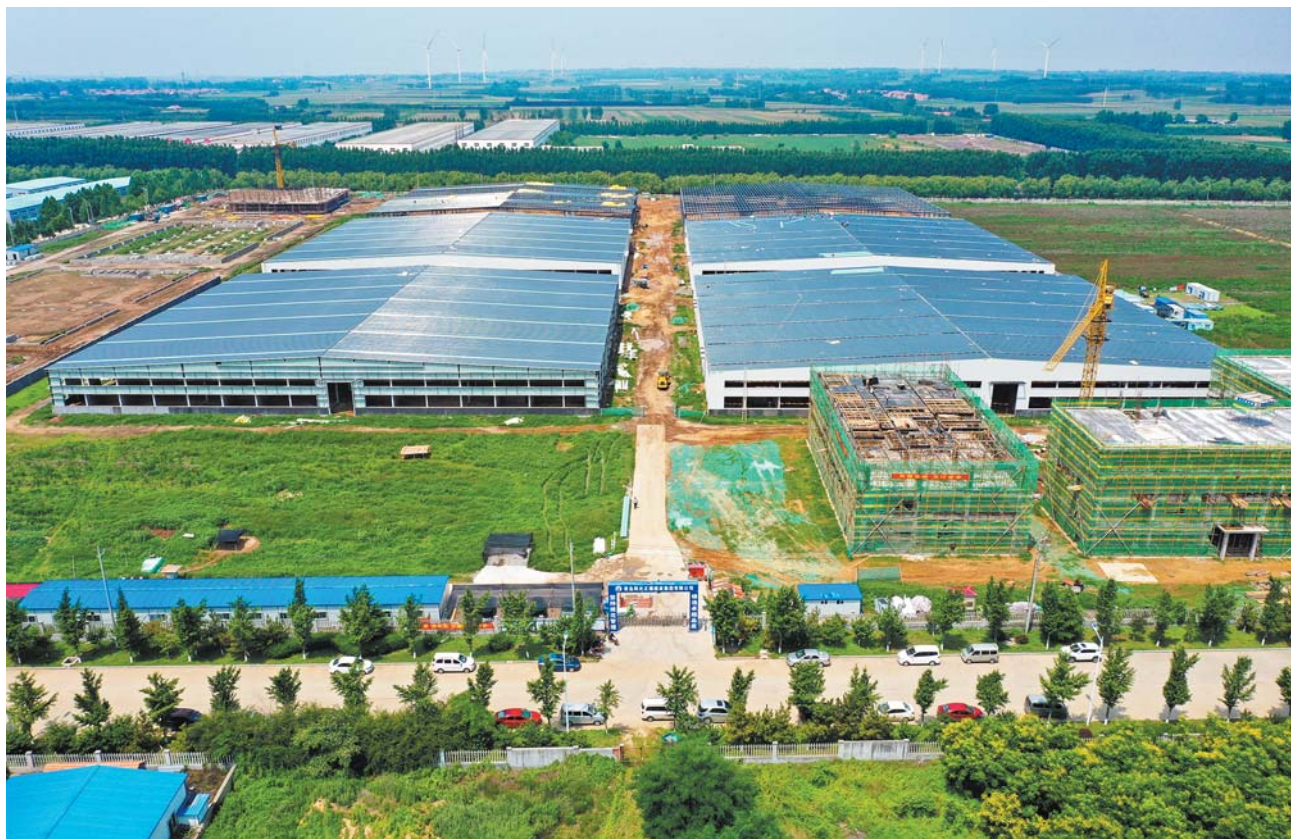
建设中的小微园和朵艺智慧家居项目。
