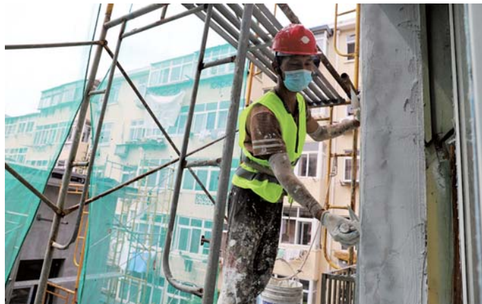
工人们正在进行施工。
