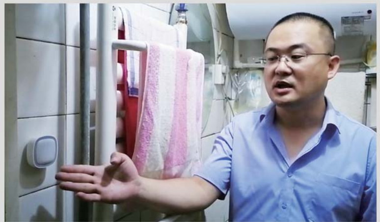
杜健介绍安装在老人卫生间门口处的红外人体感应探测器的功能。
