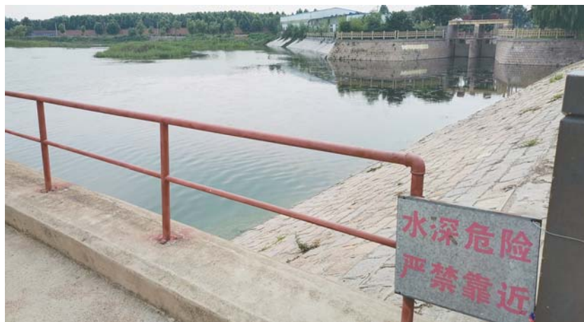
龙山街道石棚水库引水渠护栏低容易翻越。
