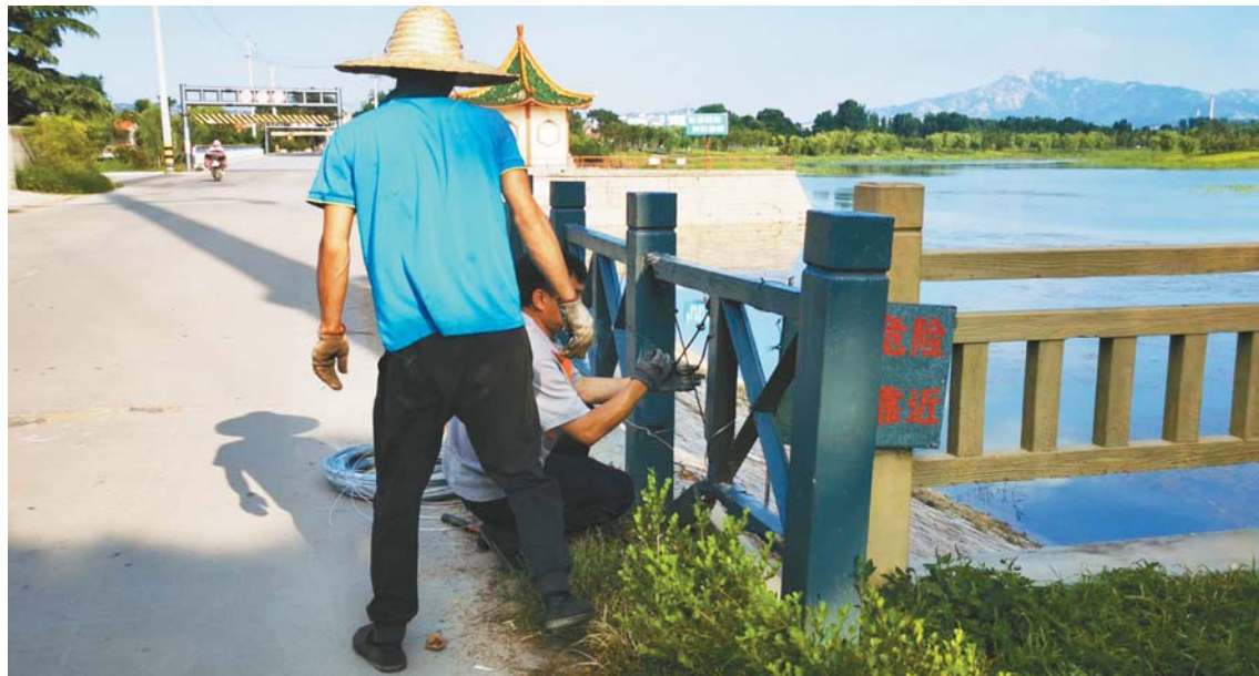
工作人员正在对破损护栏进行修补。
