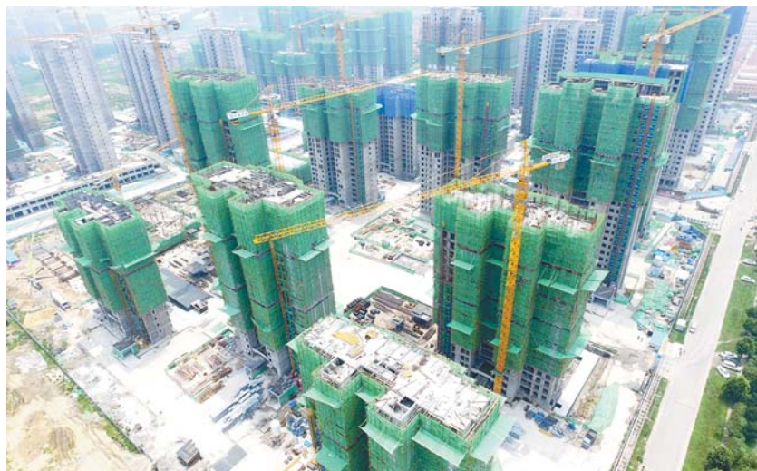
特色小镇项目建设施工。
