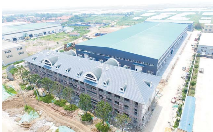
嘉和鑫智能制造项目正在进行主体施工。
