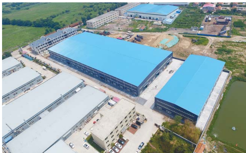
鑫拓永祥电子科技项目。
