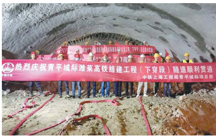
青平城际潍莱高铁结建工程隧道贯通。
