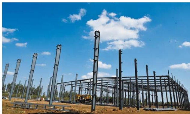
金氧牧服饰项目施工现场。
