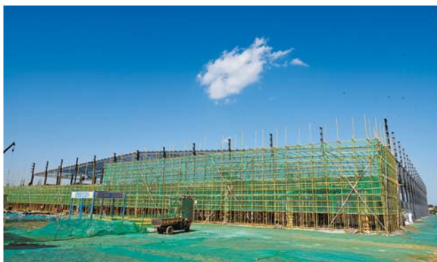
征和工业园二期项目正在加紧施工。
