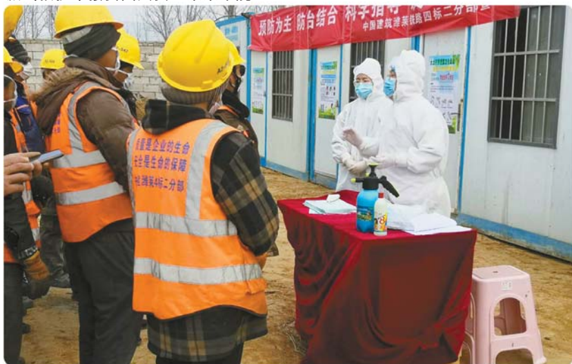
林慧明和杨铖在潍莱高铁平度施工现场向复工人员宣讲疫情防控知识。
