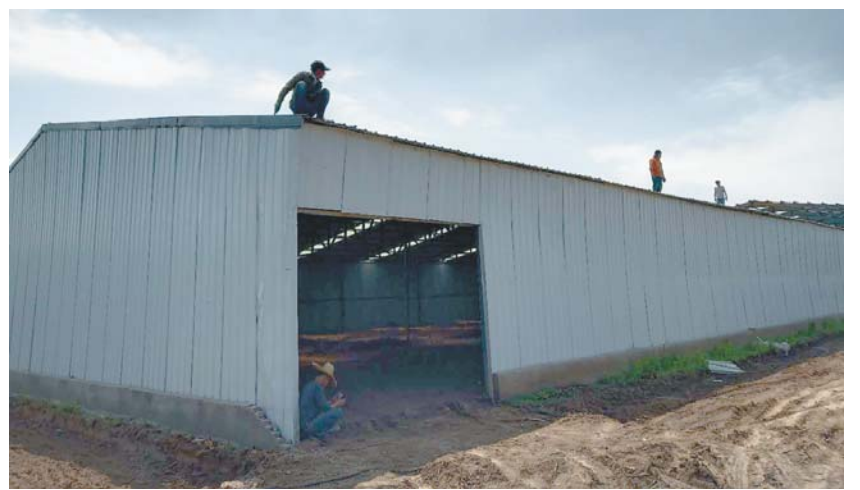
执法人员对违法钢结构建筑进行拆除。
