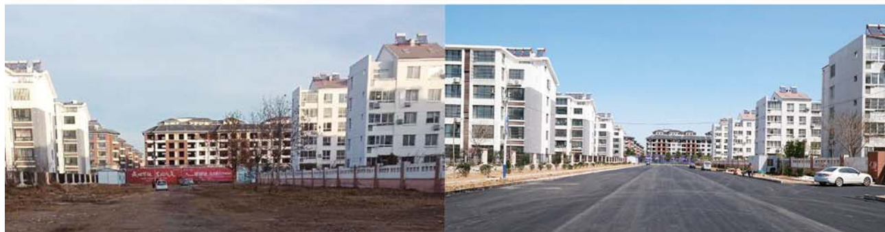
城阳星城小区道路整修后焕然一新。
