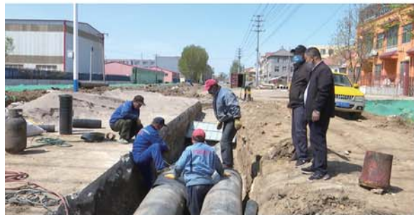
为避免重复施工，台湾大街拓宽的同时做好燃气管道、雨污分流等管道的施工。
