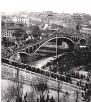
跃进桥建成后泰安桥还在。
