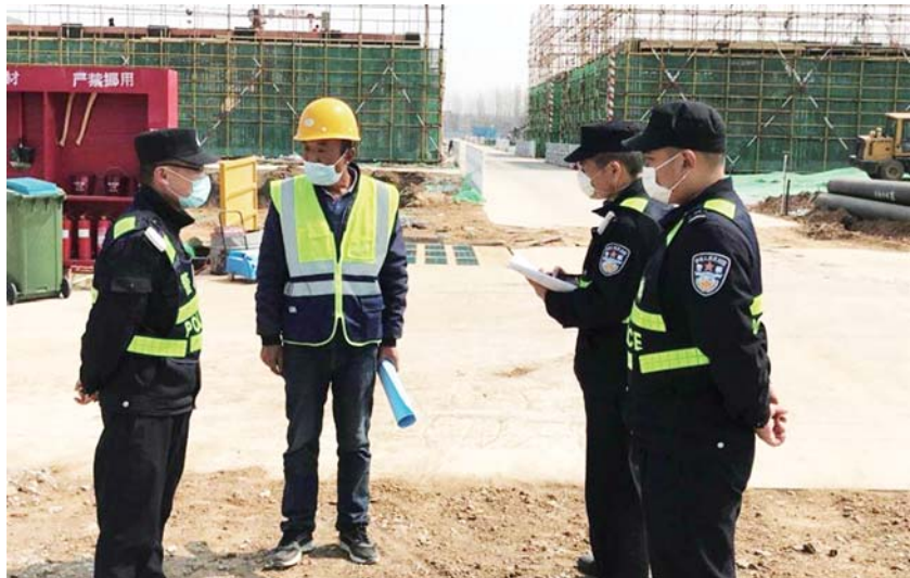
民警到施工现场了解情况。
