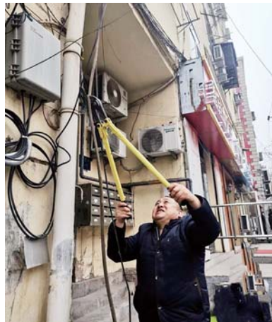
及时处理电线安全隐患。
