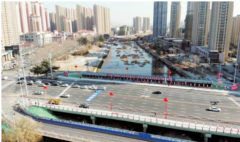
即墨区墨城路墨水河桥2019年12月31日全面建成通车。
