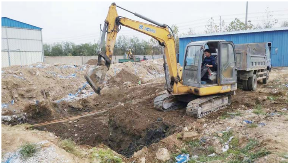
挖掘机在对涉事公司院内进行挖掘。
