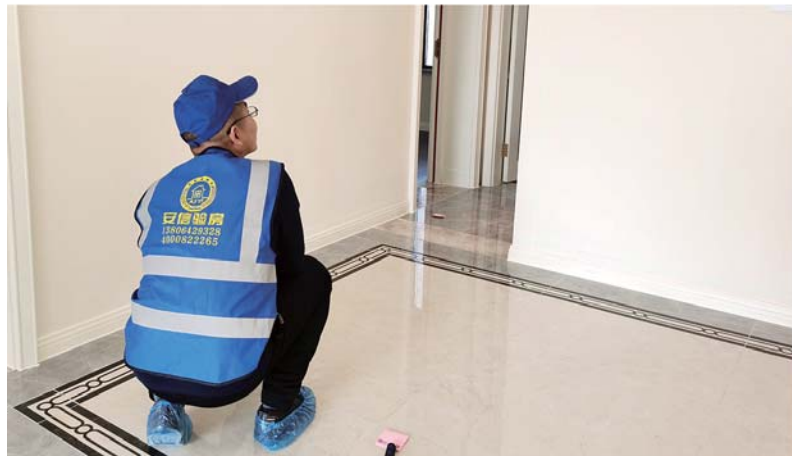
验房师对室内净高以及阴阳角垂直度进行检查
