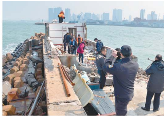
联合拆除轮渡防波堤上违建。
