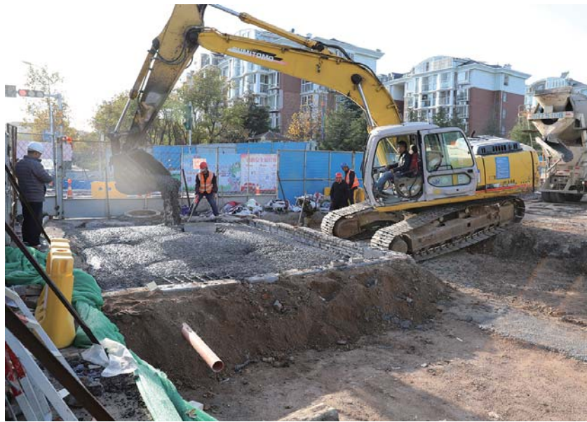
11月14日下午，道路两端的施工正在紧张进行中。
