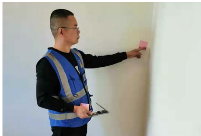
房旭良师傅对新房进行全方位查验。
