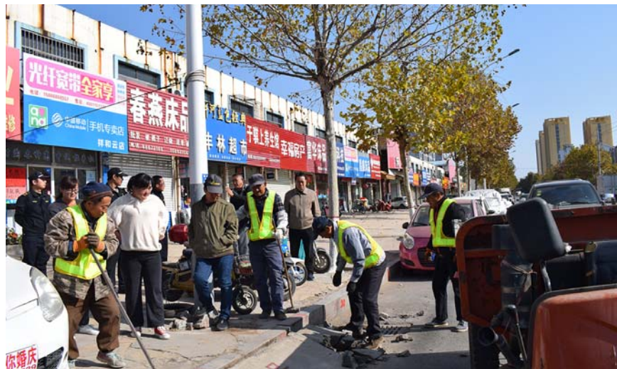
违法斜坡正在拆除。
