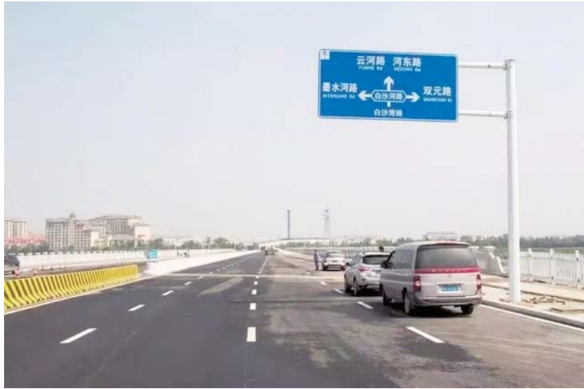
长江路白沙河大桥正式通车。
