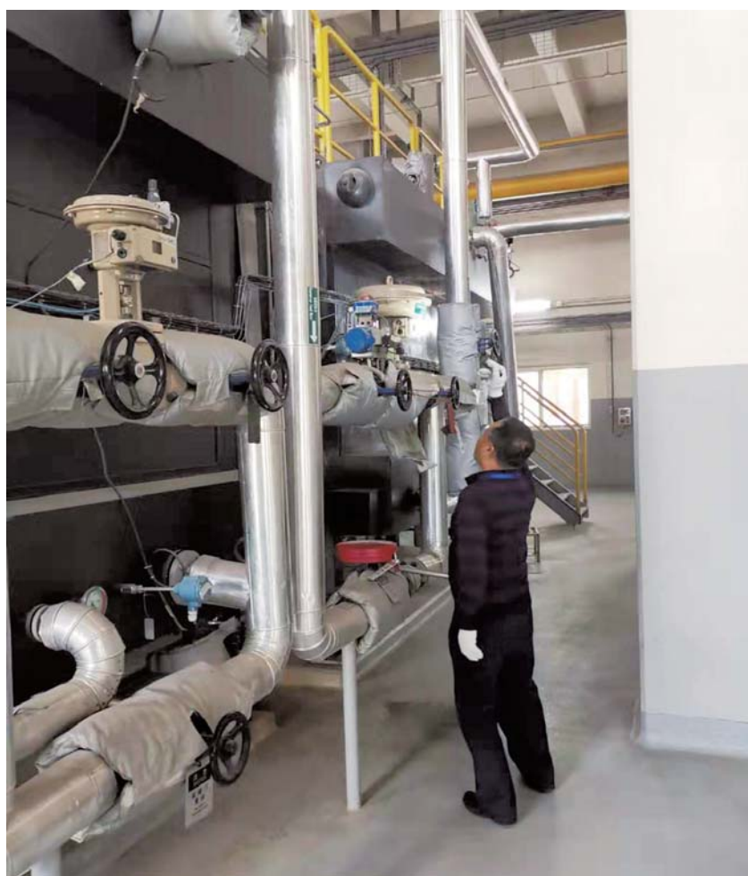
锅炉特种设备检查。
