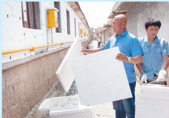
施工人员正在给房屋做外墙保温层。
