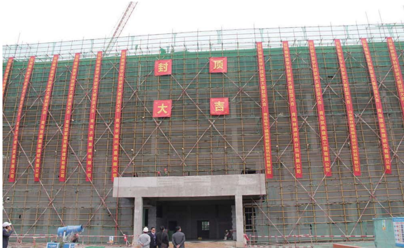
项目一期研发大楼封顶。
