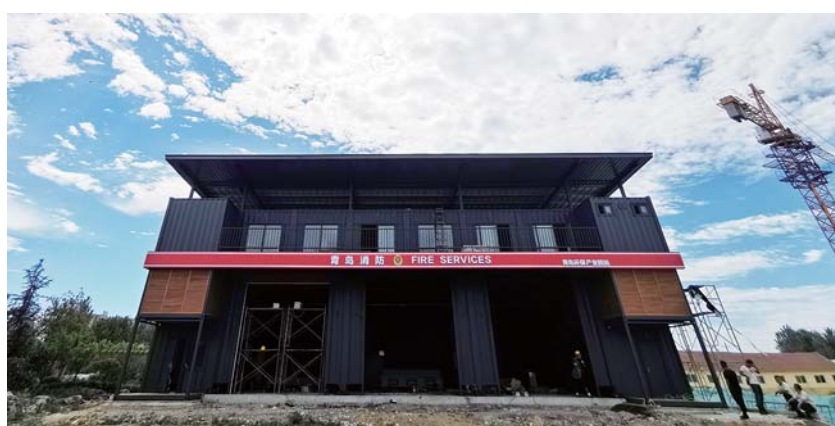
青岛市首个装配式模块化微型消防站。
