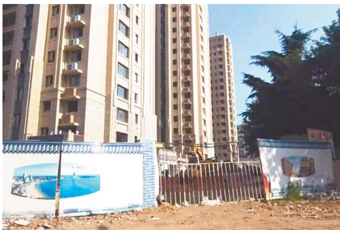
金隅和府三期的楼盖得差不多了，但是小区里面一些配套设施还在施工。
