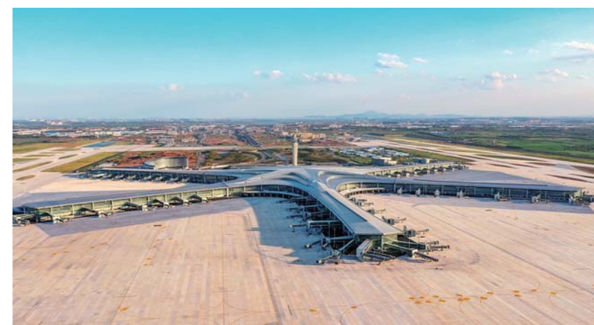
建设中的青岛胶东国际机场。
