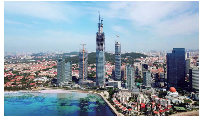
建设中的海天中心。
