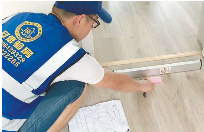
验房师正在测地面平整度。
