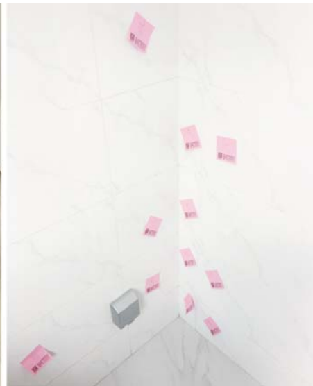
厨房墙面布满空鼓,近20处。
