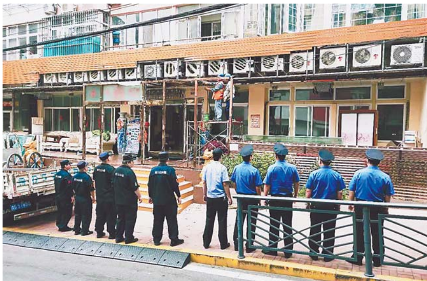
松江路13号金凤凰宾馆外立面被依法拆除。
