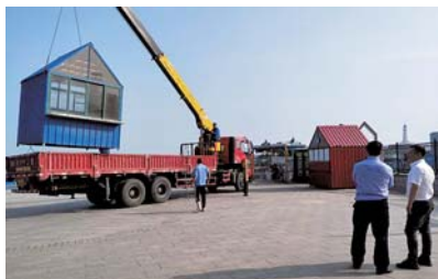
拆除极地海洋世界两处新增亭体。
