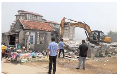
拆除午山区域违建。
