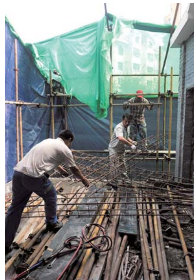
拆除荣美御园别墅一处扩建区域。
