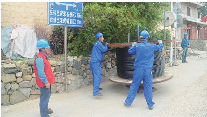
因施工机械无法进入,电力工人人工运输物料。
