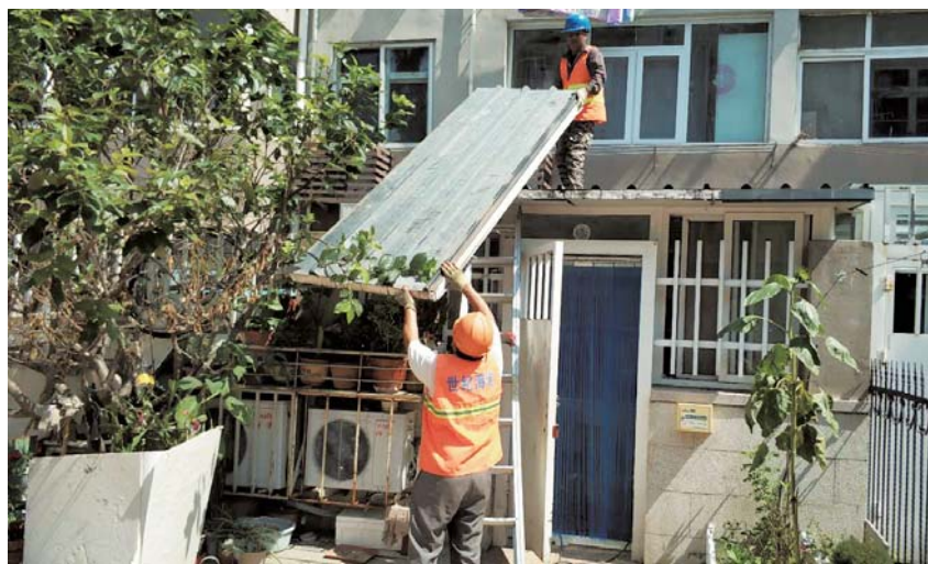
伊春路片区拆违进行中。
